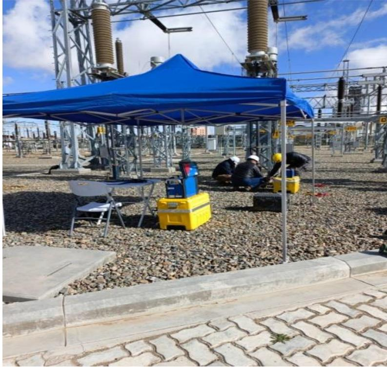
**Descripción de la foto:** Realización de pruebas de parámetros de línea en Subestación Kenko.
