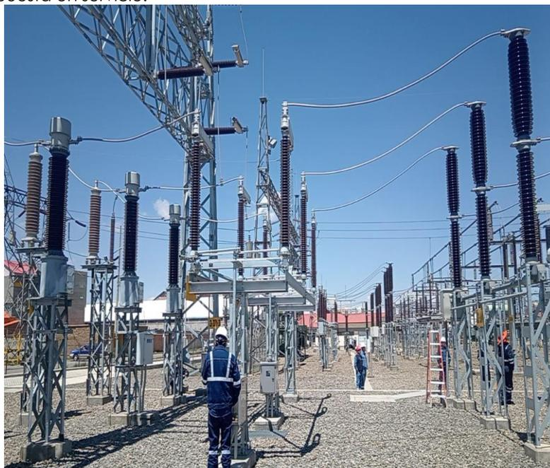
**Descripción de la foto:** Maniobras y verificación de operaciones para el cierre de seccionadores en barras de la subestación Kenko en fecha 30 de diciembre de 2024.
