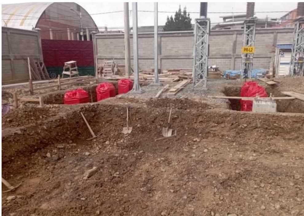
**Descripción de la Foto:** Trabajos de excavaciones, fraguado de las bases para los equipos de patio en la subestación.
