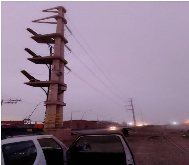
**Descripción de la foto:** Estructura de transición aérea subterránea de la línea de 115 kV Kenko - Viliroco, durante las maniobras previas a la puesta en servicio.
