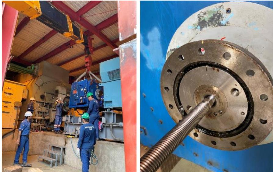
Además del reemplazo de rotor, se aprovechó el tiempo de indisponibilidad para realizar mantenimiento mayor a todos los sistemas auxiliares como calderos, bombas, motores, torres de refrigeración, pozos de agua, subestación de gas y otros. También se realizaron mejoras en sistemas de aceite de sellos de hidrógeno, SCADA y comunicaciones, sistema contra incendios, entre otros.
