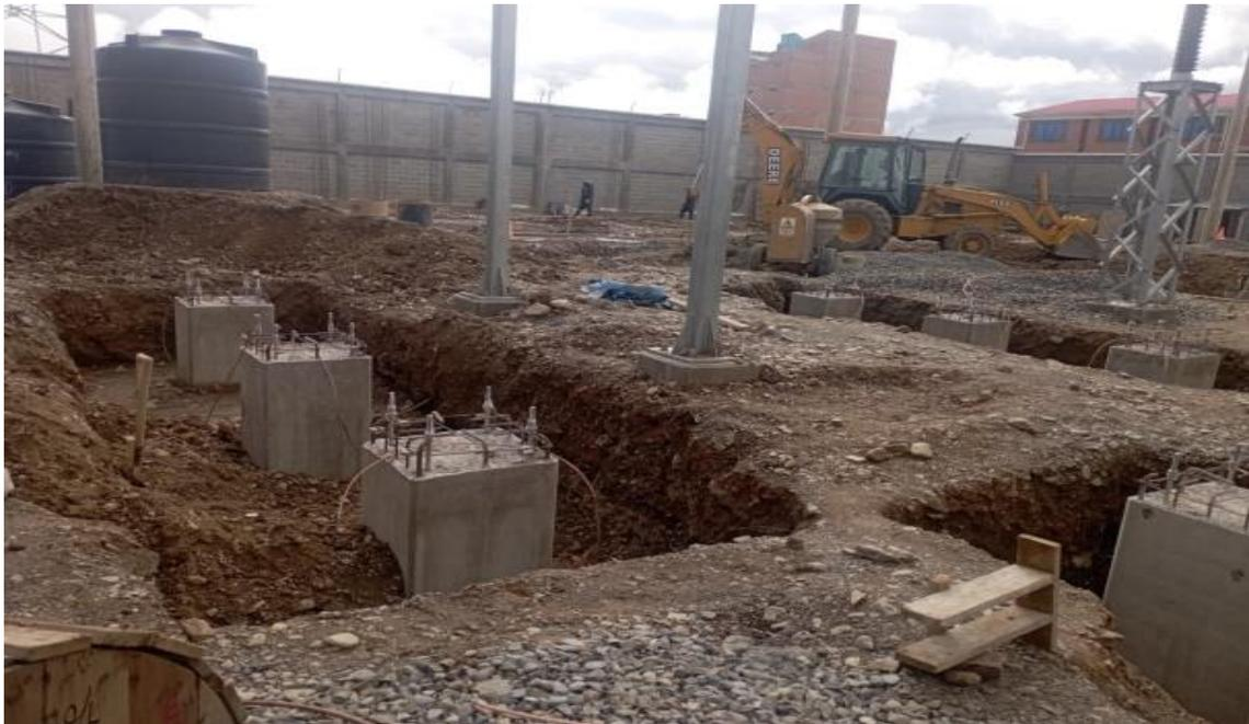
**Descripción de la Foto:** Fundaciones y bases con pernos para el anclaje de equipos en patio de la subestación.
